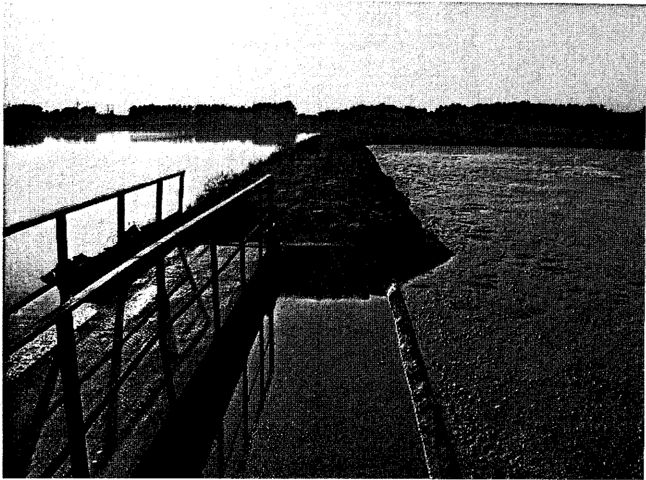
写真-2 人工池1と2との境界 (右が上流側の人工池1である)
